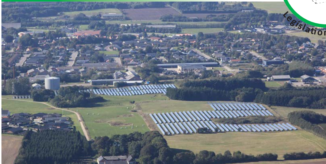
Figure 2 - Photo: © Brædstrup Fjernvarme
